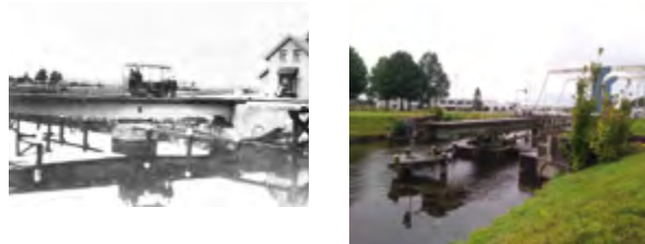
Die Drehpunktbrücke auf der Strecke der BE bei Coevorden (NL): 1910 fertiggestellt, 1944 zerstört und später wieder aufgebaut. Fotos: li.unbekannt / re. Kotte)
